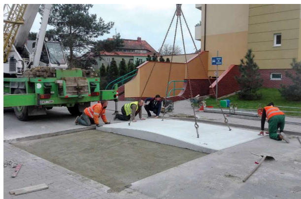
Zdjęcie 31 Montaż progu sinusoidalnego. Wrocław, Polska
