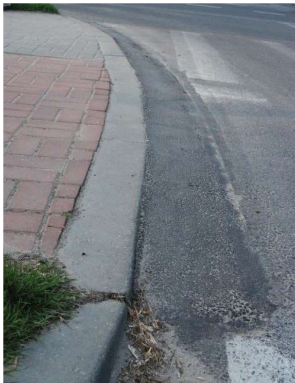
Zdjęcie 75 Wylewka z masy bitumicznej umożliwiające wjazd na krawężnik – rozwiązanie tymczasowe. Wrocław, Polska
